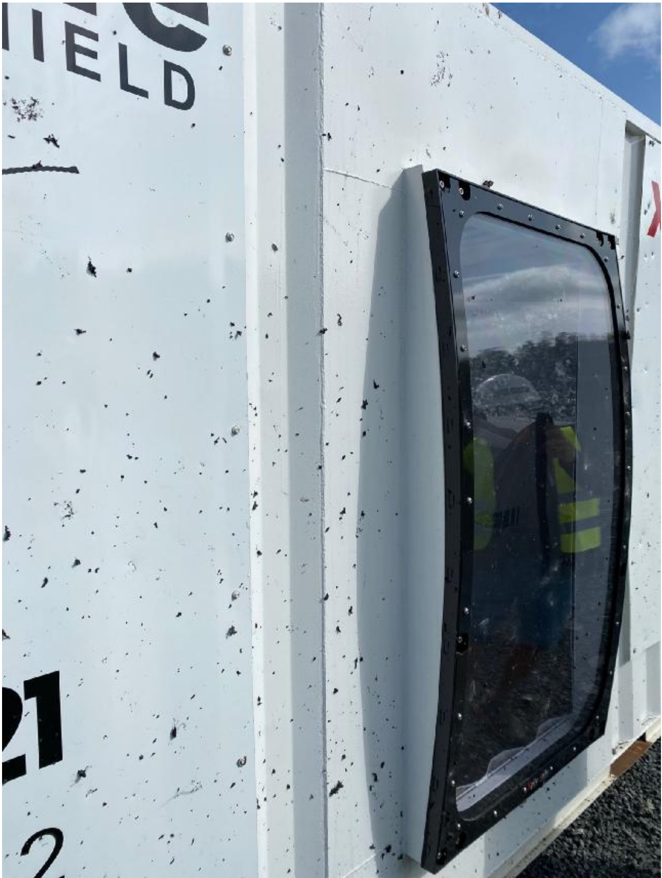
Bilde 5. Ingen spesielle skader å nevne.
