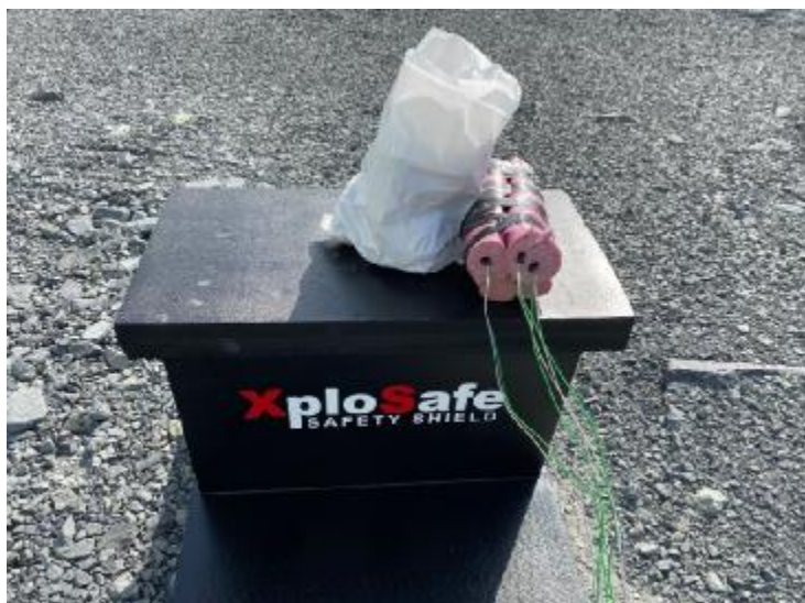
Bilde 2. 3 kg dynamitt, tennere og en pose med maskinkult.
